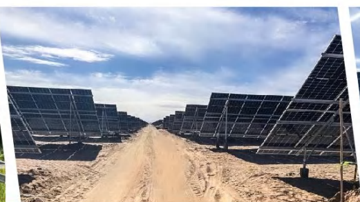
▶ 青海省海南州特高压外送基地电源配置项目
