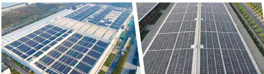
▶ 宁波申洲纺织厂房屋顶项目
